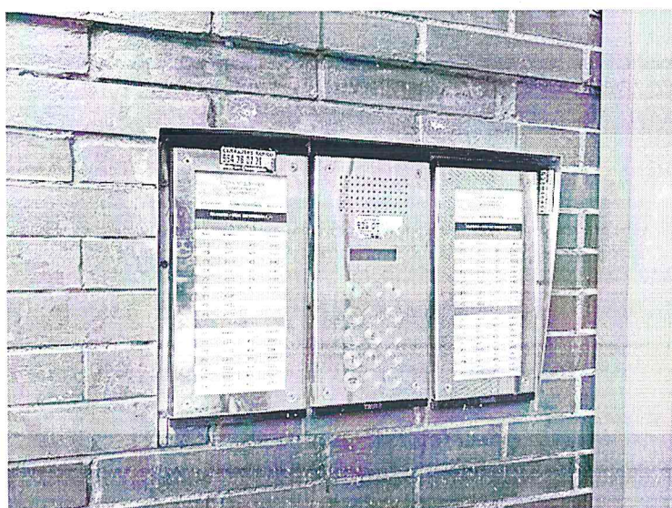
Detalle acceso a la vivienda
