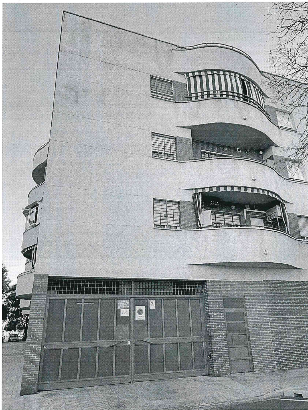
Fachada Calle Pakistán _____plazas aparcamiento
