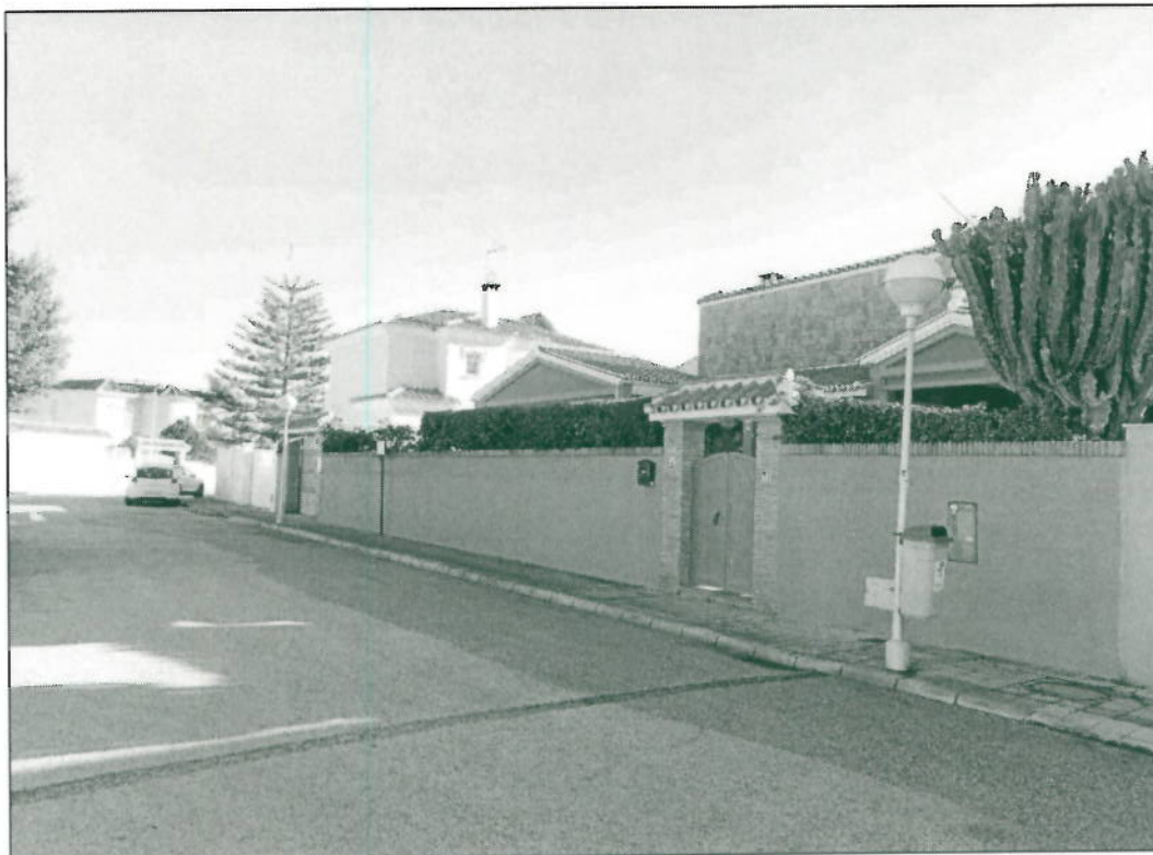
VISTA PUERTA DE ACCESO A VIVIENDA.-
