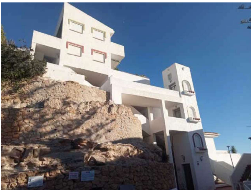
FOTOGRAFÍA DE FACHADA
