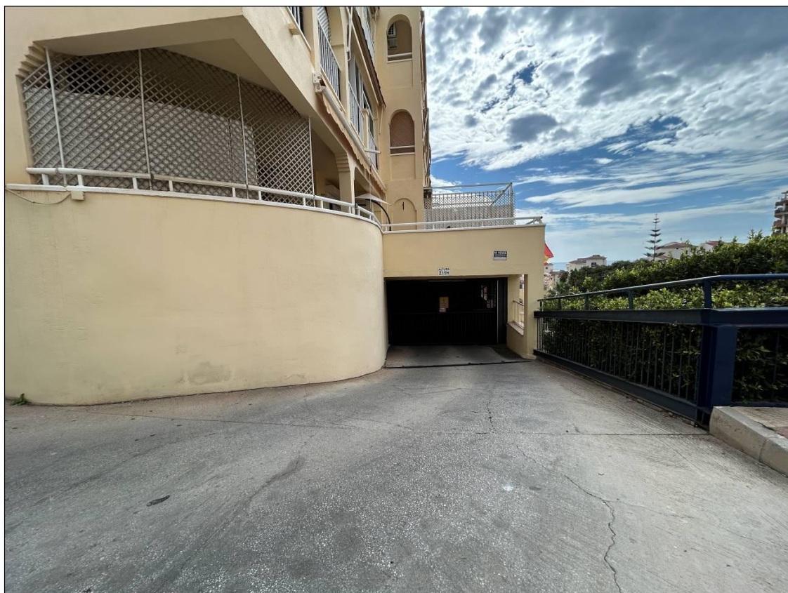
VISTA ACCESO DE RAMPA DE ACCESO A LA PLANTA SÓTANO.-
