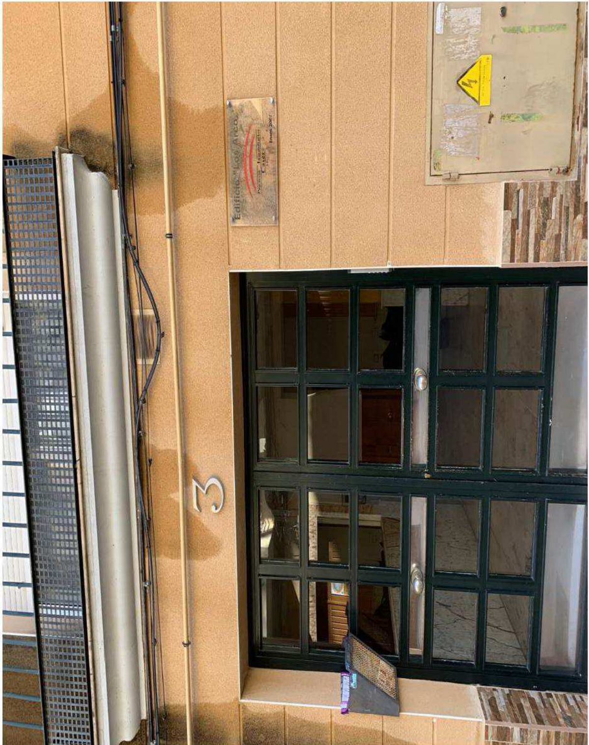
PORTAL DE ENTRADA
