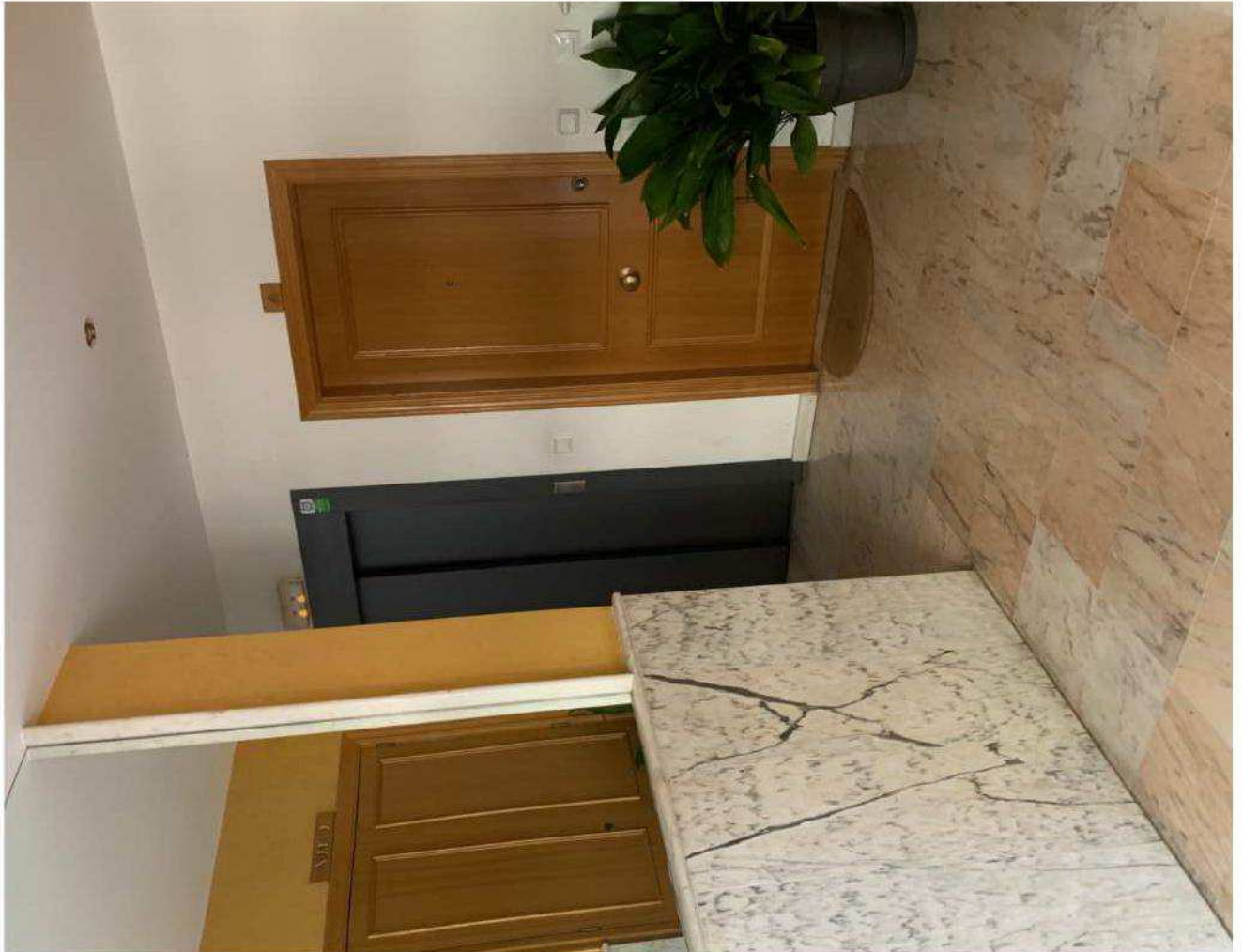
DETALLE HOLL DE ENTRADA AL EDIFICIO
